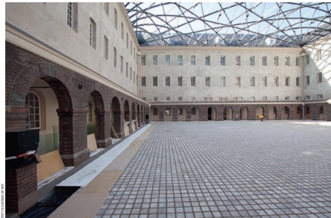
De akoestische vloer op de nieuw overdekte binnenplaats van het Scheepvaartmuseum.
